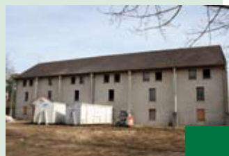
Travaux de rénovation de l'ancien Hôtel
