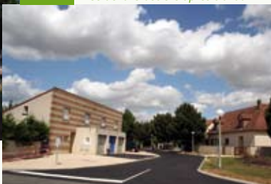
Allée de la Gibecière après travaux
