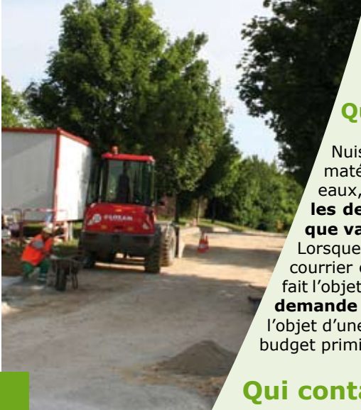
Réfection de la voirie de la rue de la Gibecière
