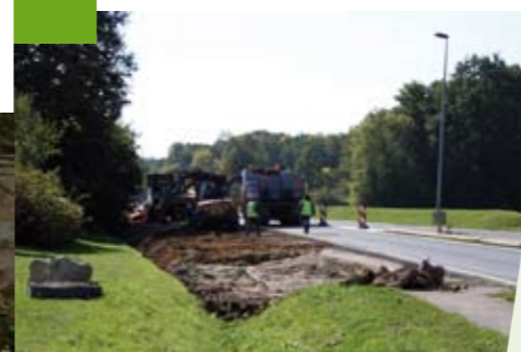
Aménagement d'une nouvelle liaison douce sur Nandy
