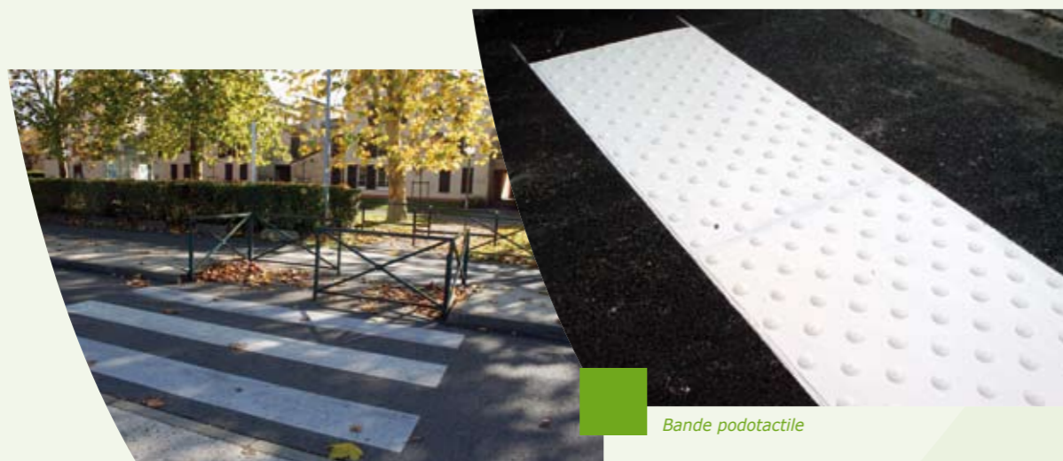
Passage piéton accessible et sécurisé aux abords de l'école des Bois
