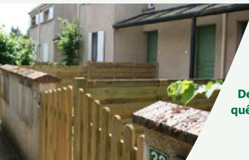
Immobilière 3 F du Balory : portillons après travaux
