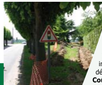
Voie piétonne rue du 24 août
