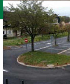
Parking rue du Stade après les travaux
