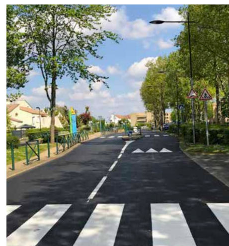
Réfection de la rue des 18 Sous avec le concours de l'agglomération GPS.
