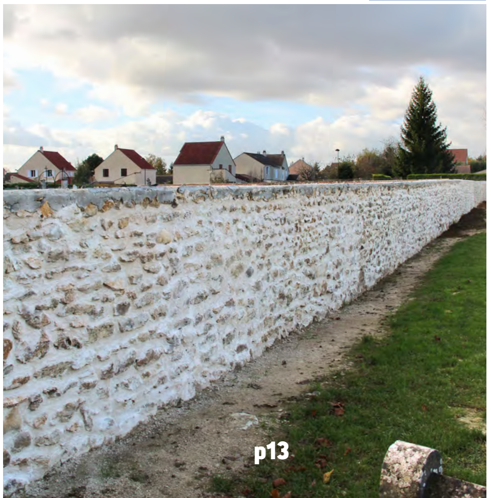
Rénovation du cimetière de Nandy.
