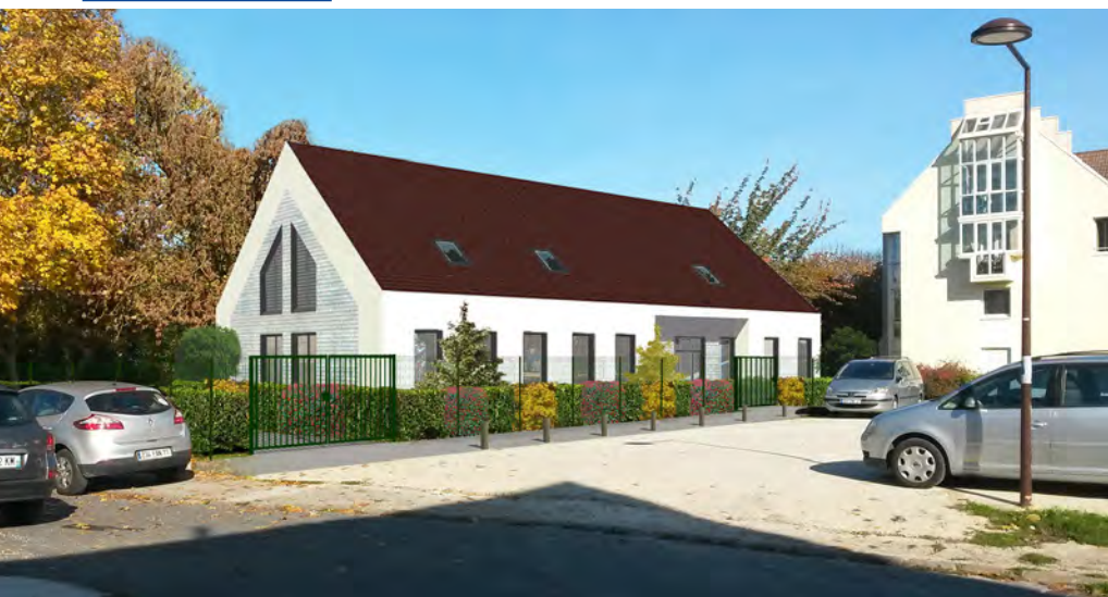
La maison médicale du quartier des Bois.
