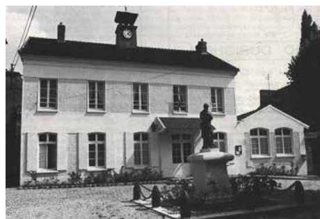
La Mairie rénovée, en 1981.
