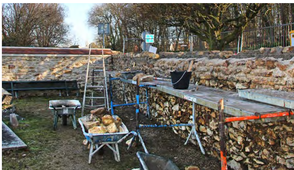
La réfection du mur du cimetière, côté rue Robert Cousin, a débuté début décembre.
